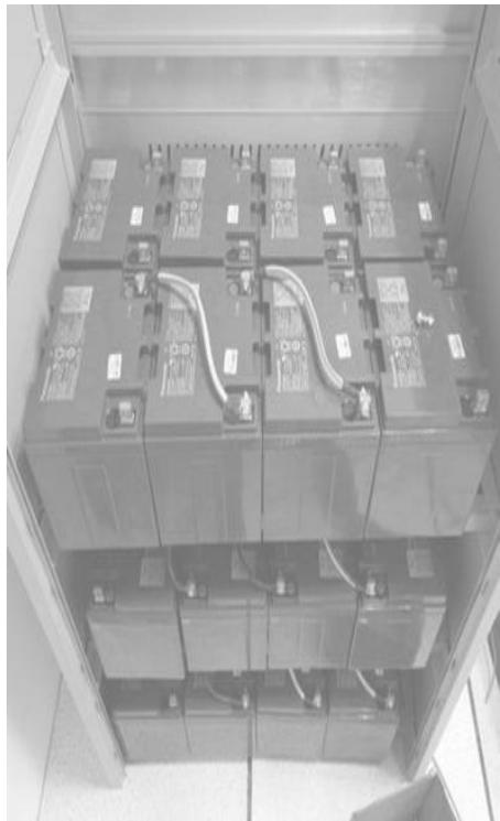
蓄电池在长期使用过程中，由于极柱密封老化失效、外壳粘接老化失效等情况都会引发蓄电池极柱爬酸和漏液现象；此外，在蓄电池的运输、安装过程中可能造成的跌落磕碰也会造成电池外壳的隐性开裂，较为隐蔽的裂纹很难被及时发现，随着运行时间的增加，最终引发电池漏液现象。泄露的电解液通常会覆盖电池端子、电池连接条以及电池架，很容易造成电池短路，从而引发火灾等事故的发生，影响电池的使用安全。
